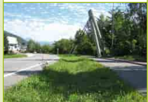
Fosso d'infiltrazione in zona industriale a Bressanone
