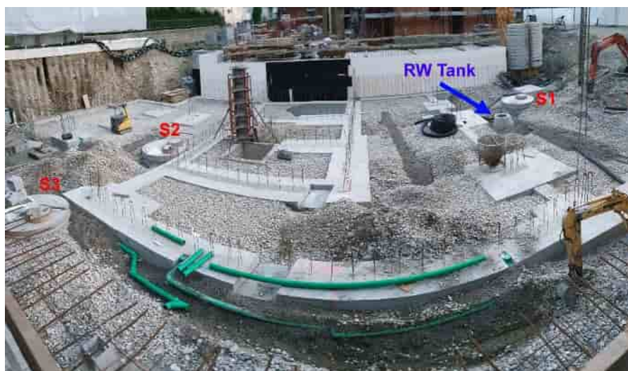
Versickerung (S1-S2-S3) und Regenwasserspeicher
