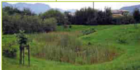
Beckenversickerung bei der Autobahnausfahrt Bozen Süd
