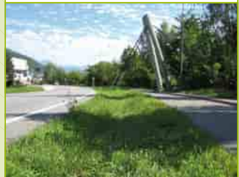
Muldenversickerung in der Industriezone Brixen
