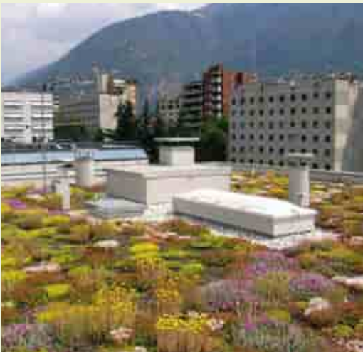
Extensivbegrünung am Dach des Wohnbauinstituts in der Drususstraße, Bozen (Foto Geom. Diego Del Monego)
