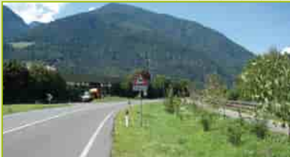
Muldenversickerung entlang der Brennerstraße in Vahrn
