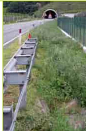
Fossi d'infiltrazione con trincea d'infiltrazione lungo la circonvallazione di San Giacomo
