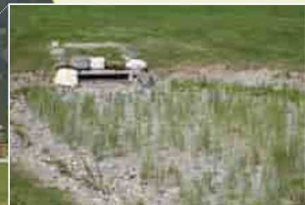
Depressione d'infiltrazione accanto al bacino di ritenzione
