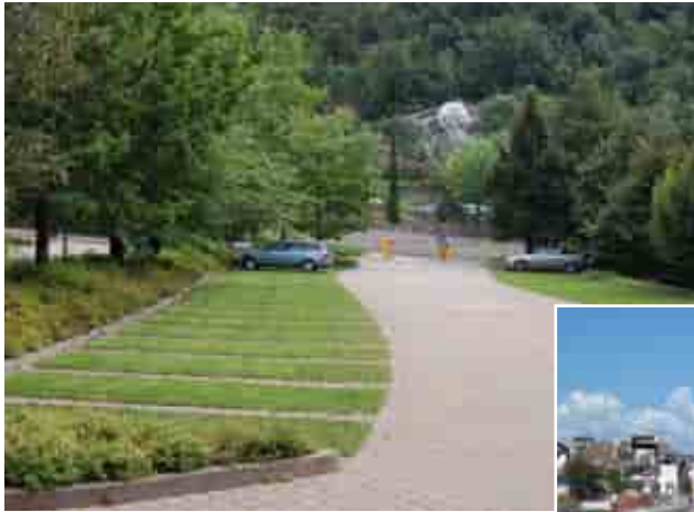
Parkplatz bei den Gärten von Schloss Trauttmansdorff in Meran (Verkehrswege gepflastert, Parkflächen aus Rasengittersteinen)
