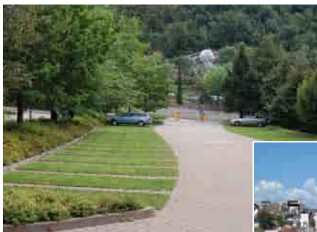
Parcheggio presso i Giardini di Castel Trauttmansdorff a Merano (Strade in masselli, parcheggi con grigliati in calcestruzzo inerbiti)
