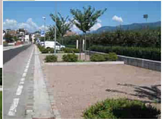
Parkflächen mit wassergebundener Decke in Neumarkt
