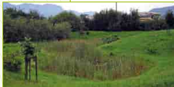
Bacino d'infiltrazione presso il casello autostradale di Bolzano Sud
