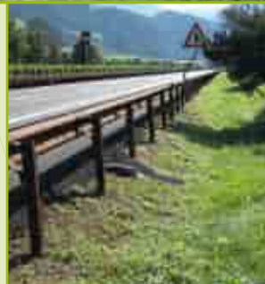
Muldenversickerung entlang der Brennerautobahn bei Trens
